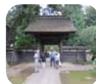
長源寺四脚門
